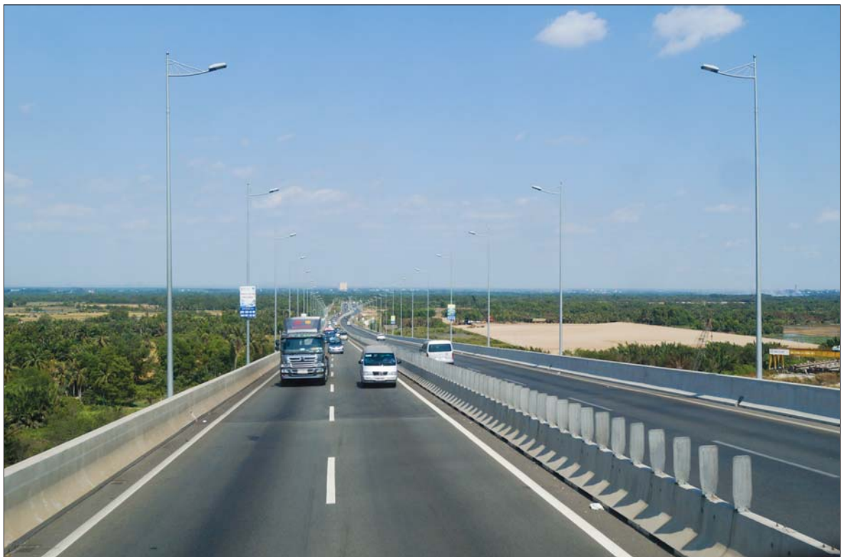
Chi phí đầu tư dự án đường cao tốc ở Việt Nam còn cao so với các nước
